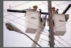
NOTIMEX (s/f). 'Técnicos de la energía eléctrica', recopilación fotográfica, cortesía de Notimex, México.
